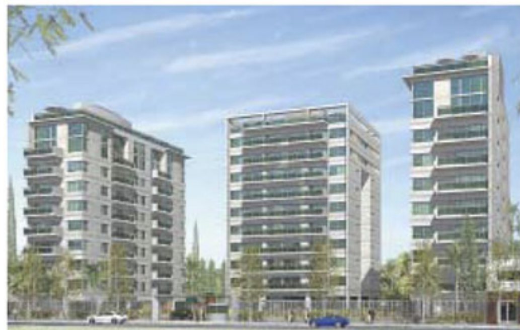
Altos de los Arroyos, en San Nicolás, está en construcción. Son tres torres de 100 departamentos y 144 cocheras, en donde el metro cuadrado cotiza a u$s 1640.
